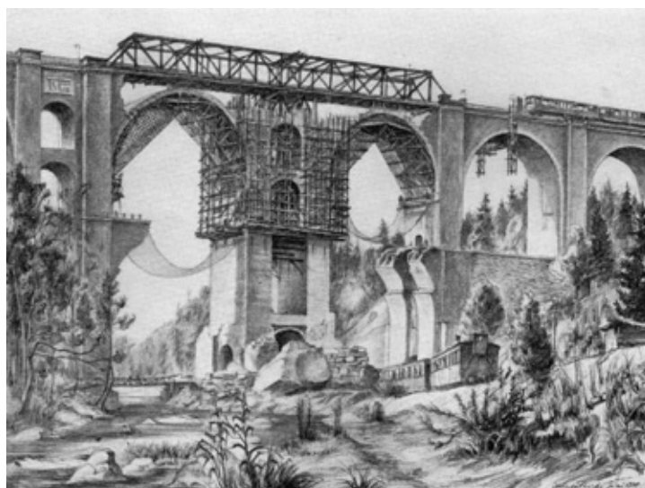
Wiederaufbau der Elstertalbrücke 1948
